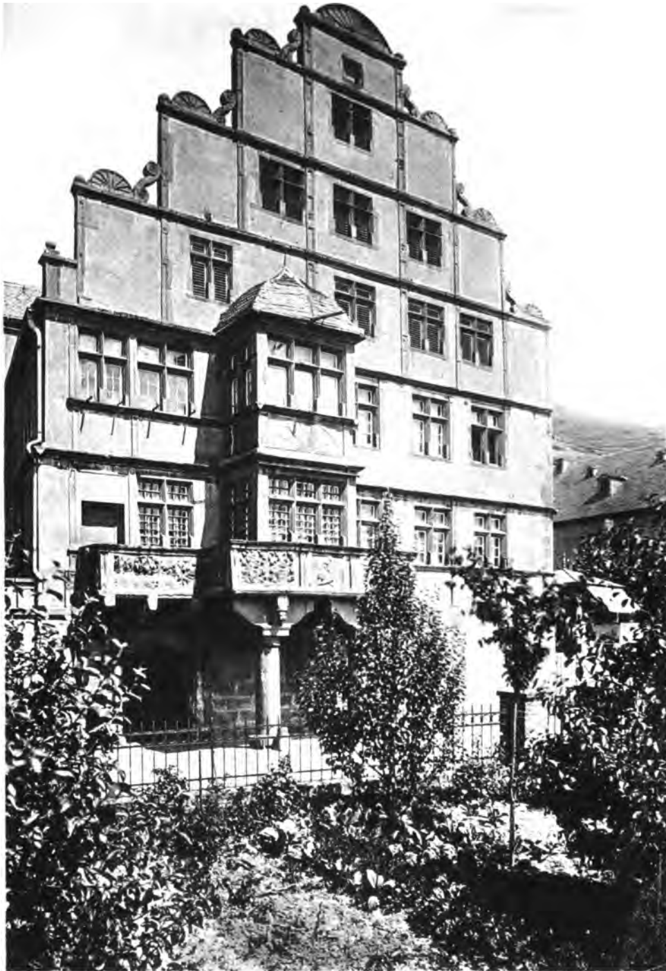
Fig. 114. Lorch. Hilchenhaus. Fassade.
